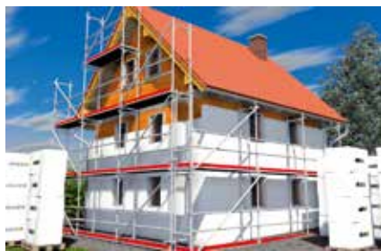
Incollaggio di pannelli isolanti per sistemi ETICS
